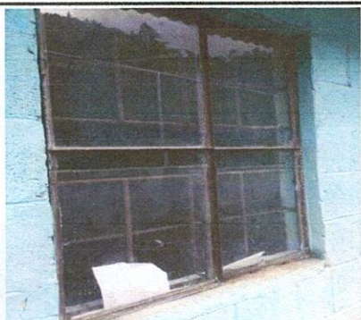
sustitución de ventanas
