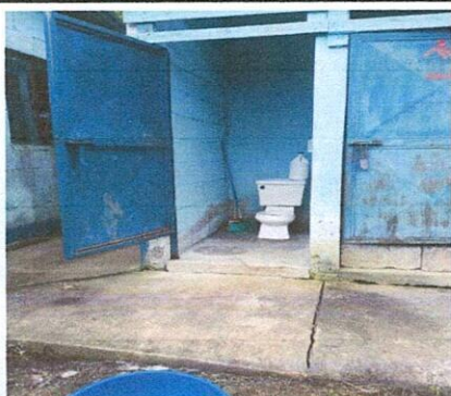
mejoramiento de modulo sanitario (cambio de baños)
