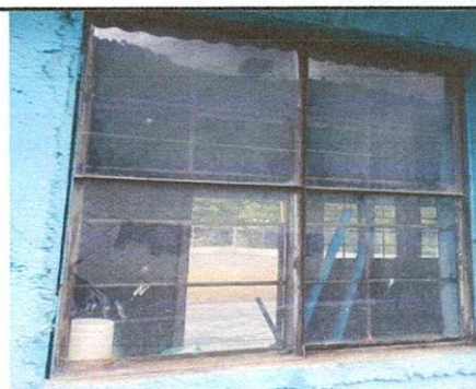
sustitución de ventanas
