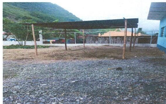
mejoramiento de estructura de techo y cubierta de lamina
